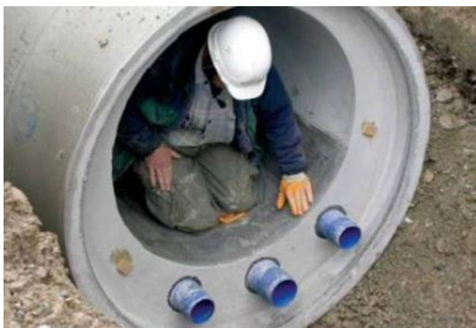
Figure 21 : Canalisation préfabriquée avec échangeur de chaleur intégré
