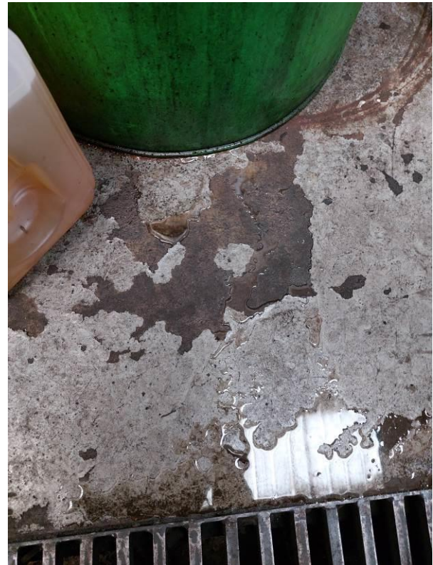
Fûts d'huiles et fuite dans l'air de lavage
