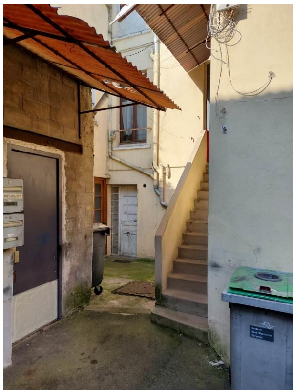
Logements au sud
